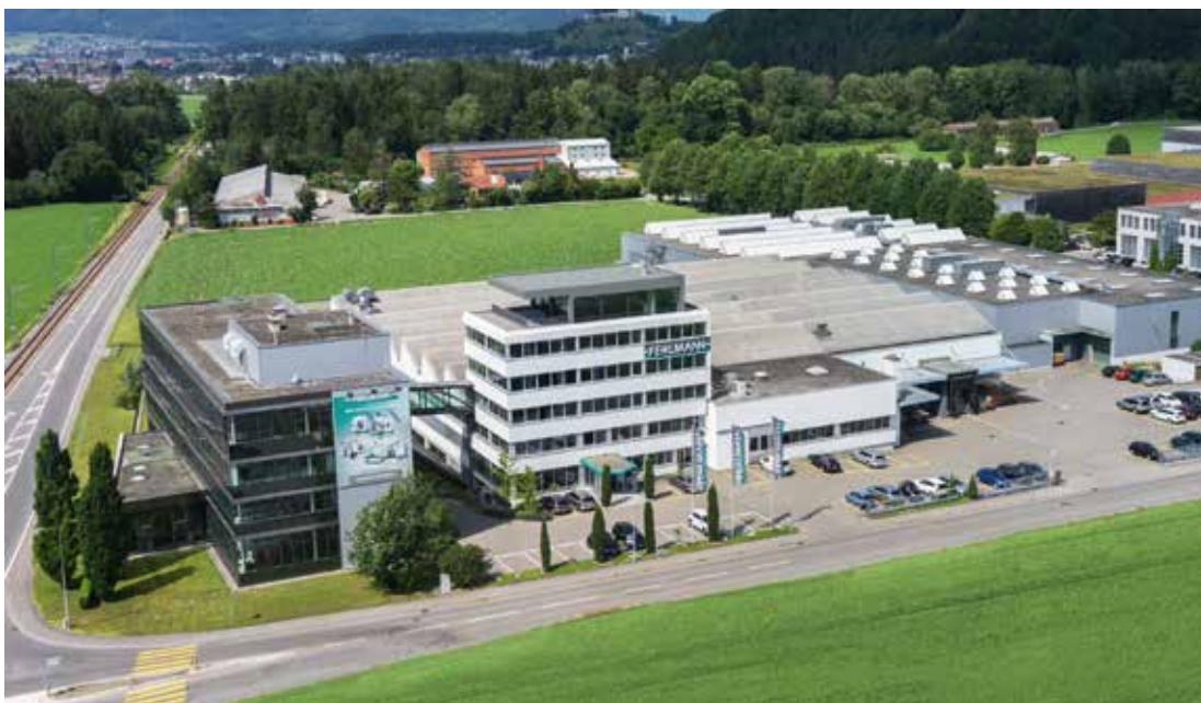
Fehlmann-AG-Kompetenzzentrum in Seon: Entwicklung, Planung, Produktion und Administration unter einem Dach.
